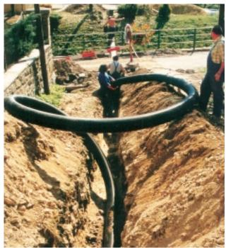
Показатель теплопроводности у РВ ниже, чем, например, у РЕХ почти в 2 раза, что означает хороший уровень теплоизоляции самой трубы.
