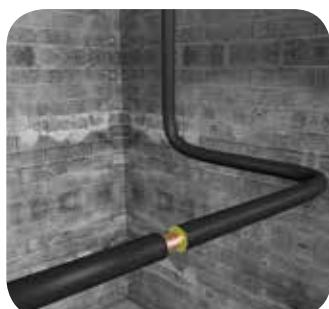
Смонтируйте следующий участок изоляции на трубопровод этим же способом натяжения и, сдвинув вплотную, приклейте торцы теплоизоляционных трубок друг другу. Зафиксируйте.
