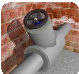
Срежьте кромки кривой линии под углом 45° по направлению к той стороне, которая будет внутренней при монтаже, затем смонтируйте деталь, тщательно склеивая концы деталей. Аккуратно приклейте деталь и к изоляционному кольцу, и к изоляции фланцев вентиля.
