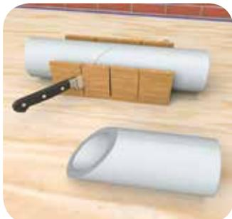
Рассмотрим второй способ монтажа теплоизоляции на Т-образном соединении труб равного диаметра.
