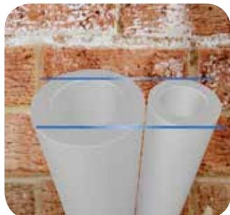
Подберите другой отрезок трубной теплоизоляции с внутренним диаметром равным внешнему диаметру трубок, используемых ранее для изоляции прямых участков трубопровода. Отрежьте от него кусок трубы нужной длины, достаточной для изоляции изгиба с нахлестом на теплоизолированные ранее прямые участки трубопровода.
