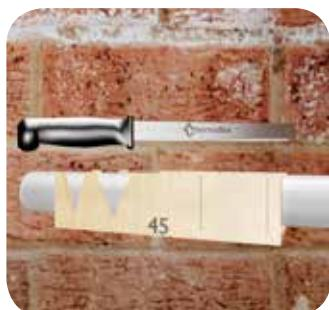
Разрежьте изоляционную трубку под углом  $45^\circ$ , используя стусло.
