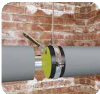
Нанесите тонкий слой клея Thermaflex на торцы под-веса и проведите монтаж теплоизоляции на прямых участках трубопровода.
