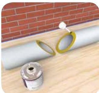
Возьмите два полученных отрезка и нанесите тонкий, ровный слой клея Thermaflex на срезы по  $45^\circ$ , дайте слегка просохнуть.
