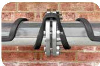
Когда нагревательный кабель длиннее обогреваемой трубы, но нет возможности уложить его по спирали или проложить в две нитки, используют укладку кабеля на трубе волнистыми линиями.
