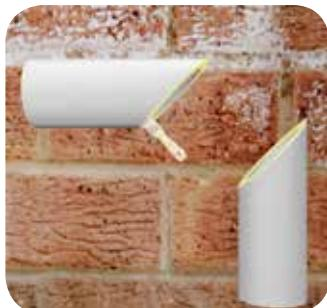
Нанесите тонкий, ровный слой клея Thermaflex на торцы соединяемых отрезков теплоизоляции, дайте слегка просохнуть. Через 2-12 минут, в зависимости от температуры окружающей среды, когда клей подсохнет (он должен перестать прилипать к пальцам), осторожно соедините отрезки изоляции, прижмите.
