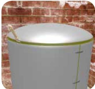
Тщательно проклейте местастыка изоляционной крышки и изоляции стенок резервуара.
