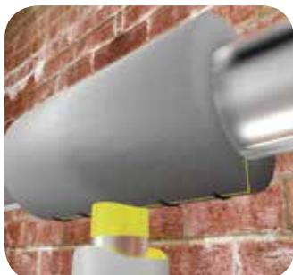
Нанесите клеевой слой на участок трубопровода, прилегающий к месту соединения труб разного диаметра, а также на торец теплоизоляционной трубы, смонтированной на отвод Т-образного соединения, прижмите.
