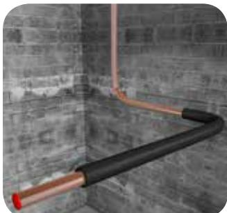
Наденьте теплоизоляционную трубку ThermaSmart PRO на трубу соответствующего диаметра и, не прикладывая больших усилий, волнообразными движениями протягивайте изоляцию по поверхности трубопровода. Для удобства монтажа допускается нанесение талька на трубу, что приводит к значительному снижению трения теплоизоляции по поверхности трубопровода и упрощает монтаж.
