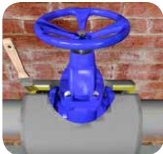
Также нанесите клей на соединяемые торцы вырезанной изоляционной детали.
