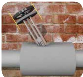
Измерьте диаметр колеса крана вентиля и диаметр механизма вентиля, в соответствии этим размерам вырежьте из теплоизоляционного листа кольцо с разрезом с одной стороны. Смонтируйте кольцо как показано на рисунке.
