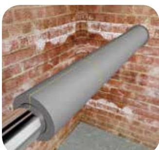
Измерьте общий диаметр трубопровода вместе с первым слоем изоляции, используя узкую полосу теплоизоляции той же толщины, что и будет использоваться для монтажа второго слоя теплоизоляции, отрежьте лист необходимого размера. Либо, если позволяют размеры, произведите монтаж второго слоя, используя трубную изоляцию, внутренний диаметр которой должен равняться общему диаметру трубопровода вместе с первым слоем изоляции.
