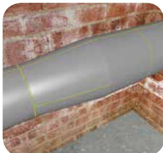
Смонтируйте на трубопровод, склеив места разреза детали и места стыков с соседними участками теплоизоляции, при необходимости зафиксируйте монтажными клипсами THERMACLIPS, затем, после полной полимеризации клея, проклейте швы лентой Терматейп СК или лентой армированной ЭКО для герметизации соединений.
