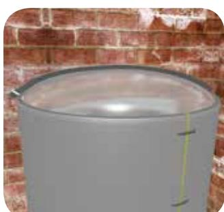
Также применяя узкую полоску теплоизоляции, измерьте поверхность крышки ёмкости.
