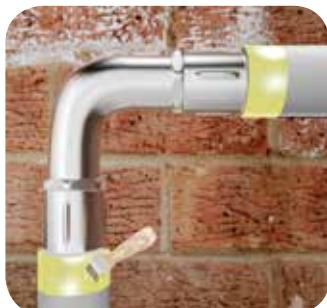
Также нанесите клеевой слой на прилегающие участки уже смонтированной теплоизоляции. Установите изолирующую деталь на изгиб трубопровода. Тщательно склейте все места разреза и местастыковки с изоляционной подложкой, используя клей Thermaflex, прижмите.
