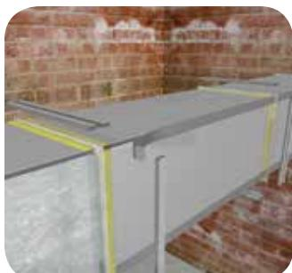
Для изоляции фланцев воздуховода вырежьте планки подходящего размера из теплоизоляционного листа, нанесите клеевой слой на места прилегания изоляции к фланцам и на приклеиваемую поверхность планок.
