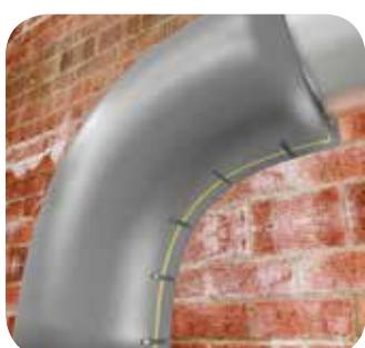
При необходимости зафиксируйте швы монтажными клипсами THERMACLIPS. После полного высыхания клея снимите клипсы и проклейте швы лентой Терматейп СК или лентой армированной ЭКО для герметизации соединений. В случае, если торцы получились не очень ровными, предварительно выровняйте их ножом круговыми движениями.
