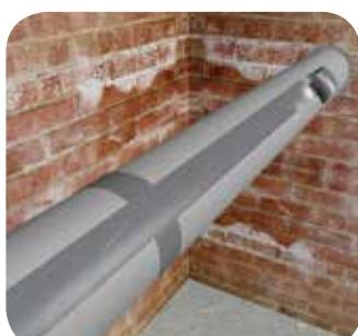
Через 24 часа, после полного высыхания клея, снимите клипсы и проклейте швы лентой Терматейп СК или лентой армированной ЭКО для полной герметизации соединений.
