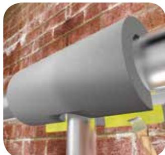
Смонтируйте полученную деталь на трубопроводе, аккуратно склеивая места разрезов, при необходимости зафиксируйте швы монтажными клипсами THERMACLIPS.
