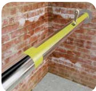
Нанесите тонкий ровный слой клея Thermaflex на трубопровод в планируемых местах склейки теплоизоляции, дайте слегка просохнуть до частичной полимеризации клея в течение 2-12 минут в зависимости от температуры среды (клей не должен прилипать к пальцам).
