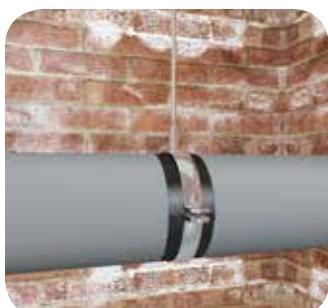
Тщательно приклейте торцы теплоизоляционного ма-териала к торцам подвеса, прижмите.
