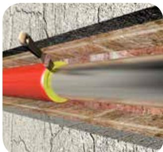
Нанесите тонкий, ровный слой клея Thermafex на торец теплоизоляционной трубы, дайте слегка просохнуть.
