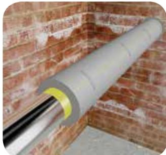
При необходимости, для временной фиксации шва используйте монтажные клипсы THERMACLIPS располагая их через каждые 20 см. В наиболее напряженных местах склейки, по необходимости, интервал может быть меньше.
