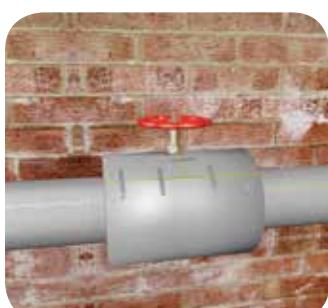
При необходимости зафиксируйте швы монтажными клипсами THERMACLIPS.
