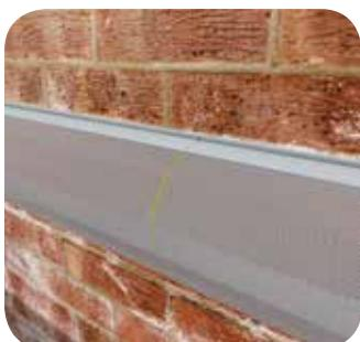
Аккуратно прижмите торцы соединяемых теплоизоляционных трубок.
