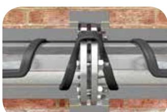
Уложите кабель на трубе волнистыми линиями, см. таблицу расчет длины греющего кабеля Traceco, закрепите по всей длине самоклеющейся алюминиевой лентой Thermaflex. Это обеспечит равномерное распределение тепла по поверхности трубопровода.
