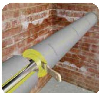
Для продолжения монтажа нанесите клеевой слой на торцевые поверхности уже смонтированной теплоизоляционной трубы и на часть прилегающего трубопровода.
