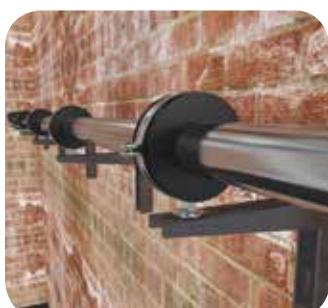
Если конструктив здания не позволяет использовать вертикальный подвес, используйте вариант подвеса на опоре, как показано на рисунке.
