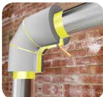
Смонтируйте деталь на изгибе трубопровода, предварительно нанеся клеевой слой на прилегающие части трубопровода для фиксации изолирующей детали, при необходимости зафиксируйте шов монтажными клипсами THERMACLIPS.
