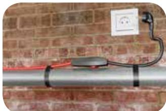
Плотно уложите кабель на поверхности трубы ровно вдоль трубопровода (см. таблицу расчета длины), закрепляя через каждые 30 см. клейкой лентой. Это обеспечит равномерное распределение тепла по поверхности трубопровода.
