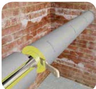
Для продолжения монтажа нанесите клеевой слой на торцевые поверхности теплоизоляции. В том случае, если торцы получились не очень ровными, предварительно выровняйте их ножом круговыми движениями.
