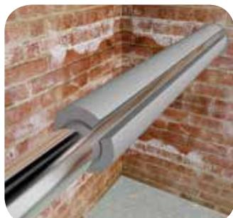
Оберните участок трубопровода изоляцией таким образом, чтобы края разреза не соприкасались.
