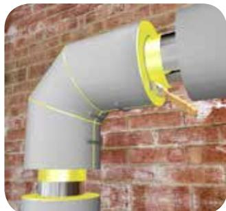
Аккуратно выровняйте поверхность стыка смонтированного углового элемента изоляции с помощью ножа.
