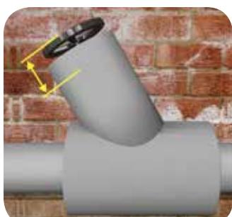
Измерьте расстояние от колеса крана вентиля до смонтированной изоляции на механизм вентиля с напуском 3-6 см.
