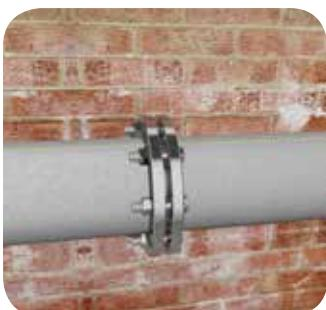
Произведите изоляцию трубопровода вплоть до фланца (см. пункт инструкции «Монтаж трубной изоляции Thermaflex на прямых участках трубопровода диаметром до 159 мм» или «Монтаж листовой изоляции Thermaflex на участках трубопровода диаметра более 159 мм», в зависимости от диаметра изолируемого теплопровода).
