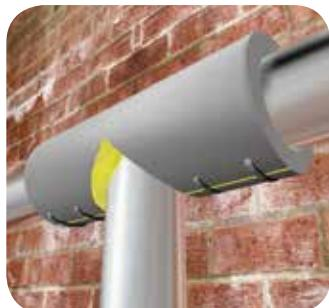
Используя стусло, произведите разрезы для получения клинообразного торца изоляционной детали.
