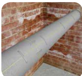
Повторите процедуру склейки разреза изоляции на следующем отрезке трубы, затем прижмите друг к другу торцы уже смонтированных соседних теплоизоляционных трубок, при необходимости зафиксируйте монтажными клипсами.
