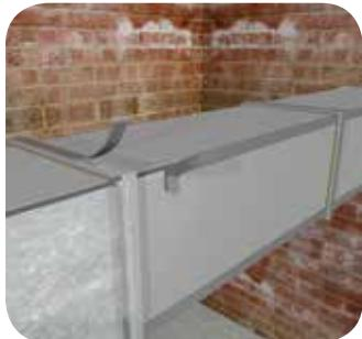
Когда клей слегка подсохнет, приклейте теплоизоляционные планки встык к фланцам, после зафиксируйте швы самоклеющейся лентой Терматейп СК.
