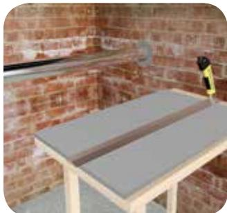
Отметьте полученный размер на листе теплоизоляции, аккуратно отрежьте.
