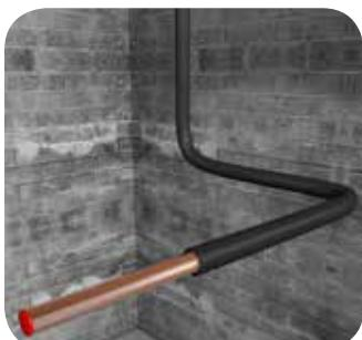
Натягивать изоляцию следует осторожно, не надо создавать излишнее давление-это может привести к деформации теплоизоляционной трубы.
