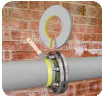
Вырежьте два кольца из изоляционного листа. Внутренние диаметры колец равны внешнему диаметру трубопровода (-2 мм), а внешний диаметр кольца должен соответствовать размерам фланца (+2 мм). Сделайте разрез для монтажа колец на трубопровод.
