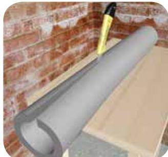
Аккуратно разрежьте трубную изоляцию по технологическому шву вдоль от начала до конца трубы. Нож необходимо держать перпендикулярно поверхности, движения должны быть плавными и уверенными, без рывков, чтобы обеспечить ровный, без разрывов, разрез.
