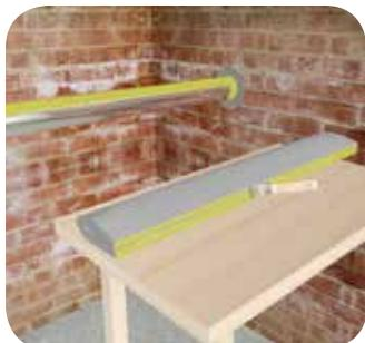
Сложите пополам отрезанный кусок листовой теплоизоляции и нанесите клей одновременно на обе торцевые склеиваемые поверхности листа.
