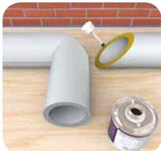
Нанесите ровный, тонкий слой клея на полученный в результате предыдущей операции срез и на срез в 45° третьего отрезка изоляции, дайте слегка просохнуть.
