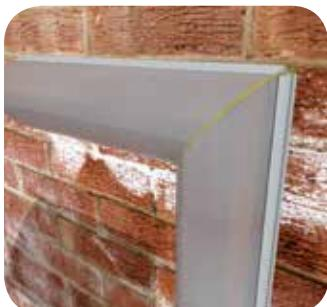
В случае монтажа теплоизоляции на углах трубопровода 90°, разрежьте изоляционную трубку под углом 45°, используя стусло, разверните один из полученных отрезков на 180°. Смонтируйте полученные детали, как показано на рисунке, предварительно нанеся клеевой слой на торцы, зафиксируйте. Проклейте швы самоклеющейся лентой THERMATAPE для герметизации соединений.
