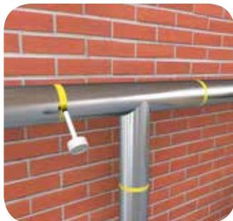
Нанесите клеевой слой на трубопровод в местах монтажа теплоизоляции, чтобы избежать смещения изоляции.
