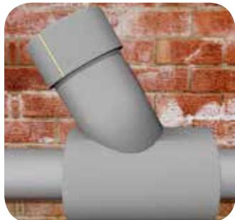
Также измерьте длину окружности этой изоляционной детали с помощью узкой полоски изоляции. Нанесите полученные размеры на изоляционный лист, вырежьте полосу, а затем - круг с диаметром равным диаметру колеса крана вентиля.
