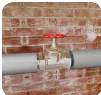
Произведите изоляцию труб вплоть до крана (см. пункт инструкции «Монтаж трубной изоляции Thermaflex на прямых участках трубопровода диаметром до 159 мм»).
