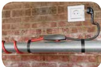
Плотно уложите кабель на поверхности трубы, наматывая его по спирали, закрепляя через каждые 30 см. клейкой лентой (см. таблицу расчета длины). Это обеспечит равномерное распределение тепла по поверхности трубопровода.
