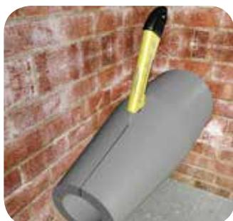
Аккуратно разрежьте изоляционную деталь вдоль по технологическому шву.
