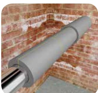
Начните монтаж второго слоя, обеспечивая несовпадение продольных и поперечных швов слоев теплоизоляции. Повторите процедуру для третьего слоя, если это необходимо.
