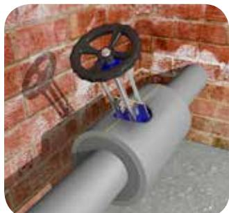
Далее произведите монтаж изоляции фланцев вентиля, используя указания из пункта «Утепление вентиля» данной монтажной инструкции.
