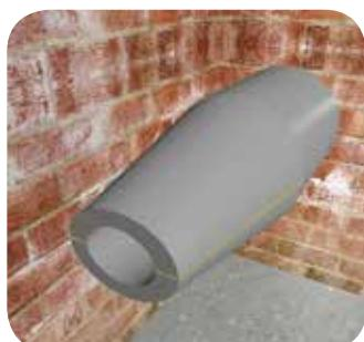
Нанесите ровный, тонкий слой клея Thermaflex на края вырезов, прижмите.
