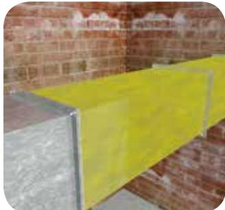
Нанесите клей Thermaflex на поверхность воздуховода, используя кисть, валик, либо пистолет-распылитель, дайте слегка просохнуть до частичной полимеризации клея в течение 2-12 минут в зависимости от температуры среды (клей не должен прилипать к пальцам).
