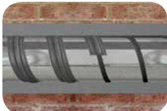
Уложите кабель на трубе по спирали с определенным шагом, позволяющим сохранить расчетную мощность(см. таблицу расчет длины греющего кабеля Traceco), закрепите по всей длине самоклеющейся алюминиевой лентой Thermaflex. Это обеспечит равномерное распределение тепла по поверхности трубопровода.
