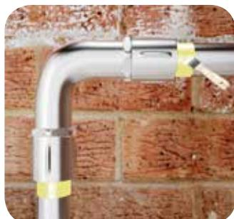
Монтаж необходимо начать с прямых участков трубопровода: используйте схему, описанную в разделе «Монтаж на прямых участках трубопровода диаметром до 159 мм». Чтобы избежать смещения изоляции, нанесите kleевой слой на участки трубопровода, прилегающие к местам увеличения его диаметра.
