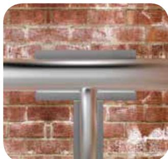
В случае изоляции Т-образного соединения труб различного диаметра необходимо взять две разные теплоизоляционные трубы подходящего к имеющимся трубам размера.
