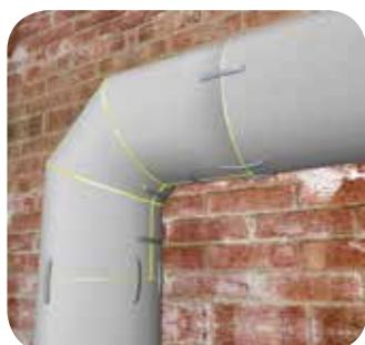
При необходимости зафиксируйте швы монтажными клипсами THERMACLIPS.
