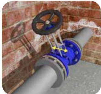
Измерьте диаметр горловины вентиля с помощью кронциркуля и длину окружности фланцев с помощью узкой полоски изоляции.
