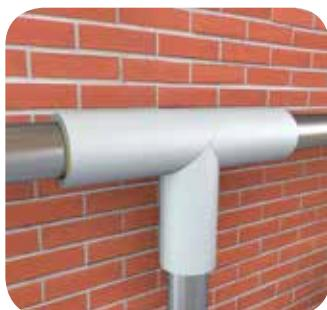
Осторожно соедините края разреза и тщательно прижмите склеиваемые поверхности.
