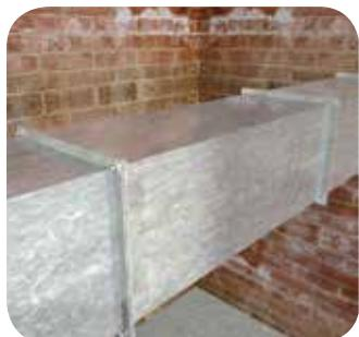
Тщательно очистите монтажную поверхность от пыли, грязи и старой отслаивающейся краски с помощью металлических щёток и ветоши. Для исключения повторного оседания пыли на монтажную поверхность можно использовать промышленные пылесосы. Так же необходимо очистить поверхность от жира и влаги. Для очистки рекомендуется применять разбавитель-очиститель для клея Thermaflex.
