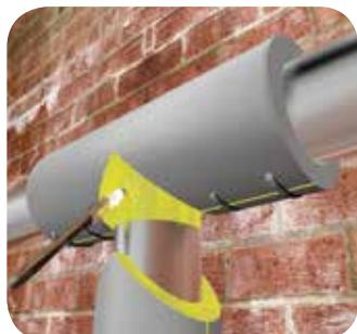
Нанесите клеевой слой на трубопровод в месте соединения двух труб, затем смонтируйте меньшую деталь, подготовленную для отвода Т-образного соединения.
