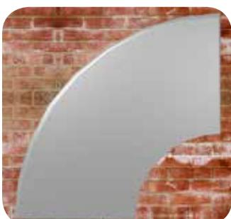
Аккуратно вырежьте по полученному шаблону две изоляционные детали.
