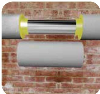
В процессе монтажа последнего участка теплоизоляции на трубопроводе образуется неизолированный участок, для которого необходимо вырезать кусок трубной изоляции чуть большей длины на 3-5 мм., чем длина самого участка. Тем самым исключается появление зазоров, которые могут привести к тепловым потерям на данном участке.
