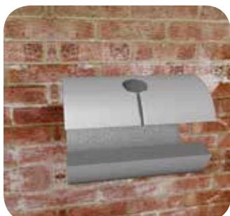
Отрежьте кусок теплоизоляционной трубы нужной длины, достаточной для изоляции крана с нахлестом на смонтированную ранее изоляцию. Разрежьте изоляцию вдоль, затем выполните продольный разрез посередине. С помощью пробойника сделайте круглое отверстие, равное диаметру ножки крана.
