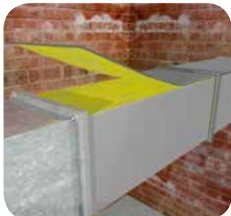
Также нанесите клей на поверхность теплоизоляционного листа.
