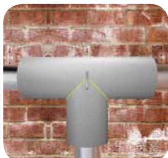
При необходимости зафиксируйте швы монтажными клипсами THERMACLIPS. Через 24 часа, после полного высыхания клея, снимите клипсы и проклейте швы лентой Терматейп СК или лентой армированной ЭКО для герметизации соединений.
