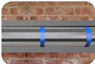
В большинстве случаев нагревательный кабель Traceco монтируется снаружи трубопровода. Плотно уложите греющий кабель на поверхности трубопровода, закрепите самоклеющейся алюминиевой лентой Thermaflex с шагом в 30 см. См. таблицу расчет длины греющего кабеля Traceco.
