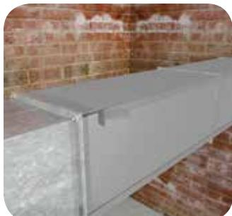
Зафиксируйте стыки самоклеющейся лентой Терматейп СК.
