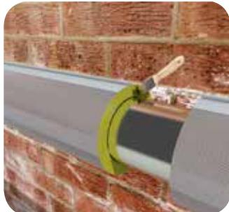
Нанесите клеевой слой на торцы соединяемых трубок, смонтируйте изоляцию на следующий участок трубопровода. Рекомендуется закрывать замок в направлении уже установленного изоляционного материала.
