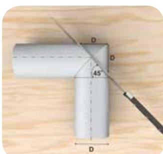
Затем сделайте разрез полученной детали как показано на рисунке: нож должен располагаться перпендикулярно линии склейки двух деталей, и, соответственно, под  $45^\circ$  к осям вращения каждого из двух склеенных отрезков трубной теплоизоляции.
