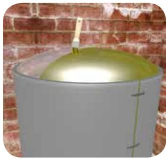
Нанесите тонкий, ровный слой клея Thermaflex на всю поверхность крышки резервуара.
