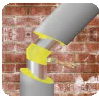
Аккуратно натяните полученные детали на трубопровод волнообразными движениями, без усилий, предварительно нанеся клей на торцы изолирующих деталей и трубопровод на месте стыка для фиксации теплоизоляционного материала.
