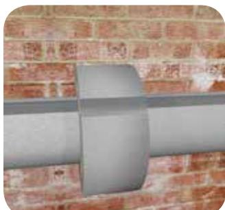
Через 24 часа, после полного высыхания клея, снимите клипсы и проклейте швы лентой Терматейп СК или лентой армированной ЭКО для герметизации соединений.
