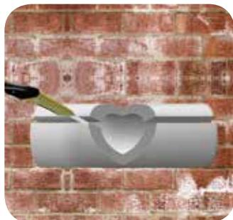
Смонтируйте изоляционную деталь на трубопровод, аккуратно склейте места разрезов, зафиксируйте швы монтажными клипсами THERMACLIPS.
