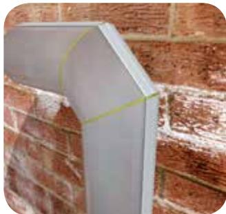
Если кривизна колена позволяет, можно протолкнуть трубку Thermafex Ultra M через колено: для облегчения процесса замок должен быть закрыт на дину около 30 см. вдоль соседнего с коленом участка. Если же нет, то изоляцию колена можно провести методом сегментирования, описанным в пункте «Изгиб трубопровода 90°. По радиусу»
