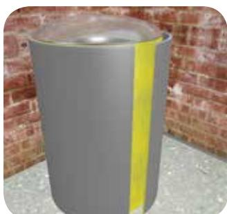
Перенесите полученные при измерении размеры на лист теплоизоляции, вырежьте деталь по разметке, затем нанесите клеевой слой на всю поверхность листа. После того, как клей слегка просохнет, смонтируйте деталь на ёмкость, прижимайте материал к монтажной поверхности, прикатывая его монтажным роликом для удаления пузырьков воздуха из места склейивания и для обеспечения максимальной адгезии.
