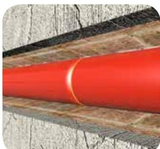
Смонтируйте следующую трубку на трубопровод, затем также нанесите слой клея на торец. Через 2-12 минут, в зависимости от температуры окружающей среды, когда клей подсохнет (он должен перестать прилипать к пальцам), осторожно соедините торцы теплоизоляционных трубок, зафиксируйте.
