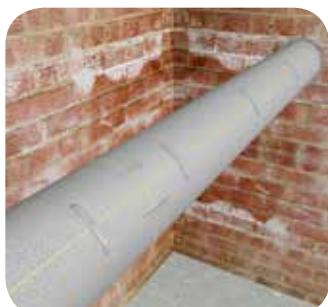
Склейте соседние участки теплоизоляции и при необходимости зафиксируйте швы монтажными клипсами THERMACLIPS.
